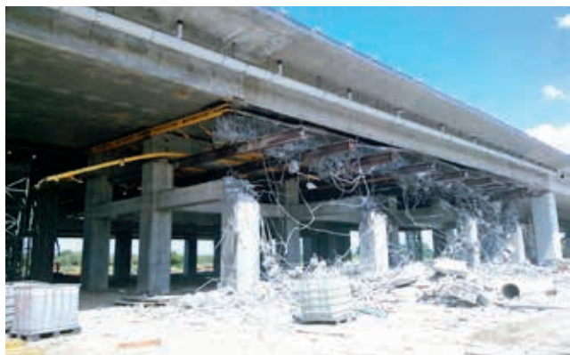
Ryc. 6. Stanowiska montażowe dla estakad zachodniej oraz wschodniej obiektu E-118
