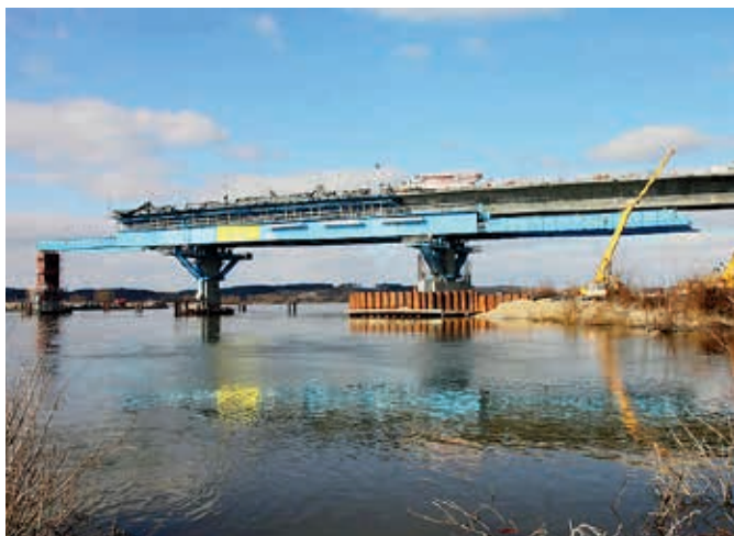
Ryc. 11. Trawler przestawny do budowy metodą MSS – realizacja mostu M-4 w Kwidzynie
