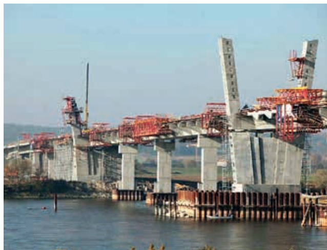
Ryc. 13. Widok mostu M-4 w trakcie realizacji
