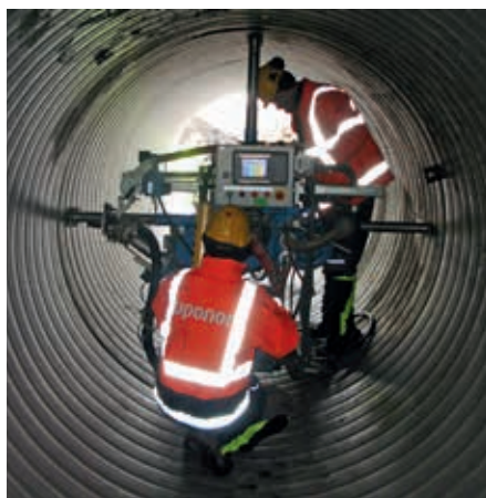
Spawanie ekstruzyjne maszyną WLI-3000
