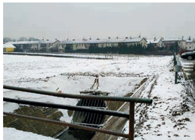
Zakończenie prac. Teren przeznaczony do rekultywacji, fot. D. Sołtys
