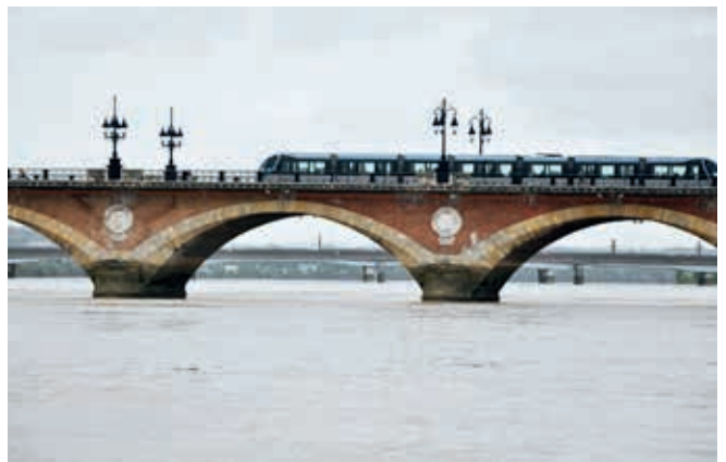
Most Saint Pierre w Bordeaux (obiekt nr 11)
