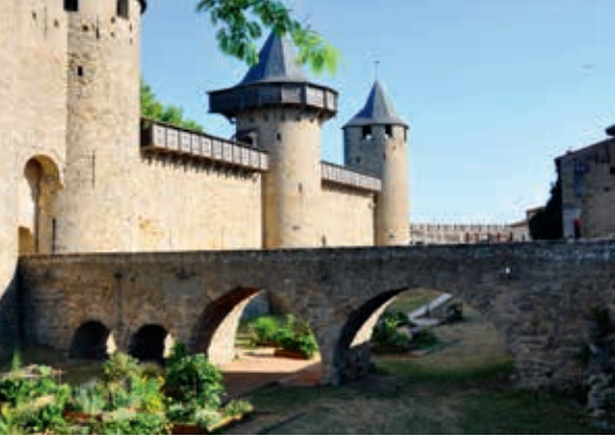
Łukowy most kamienny do zamku w Carcassonne (obiekt nr 1)
