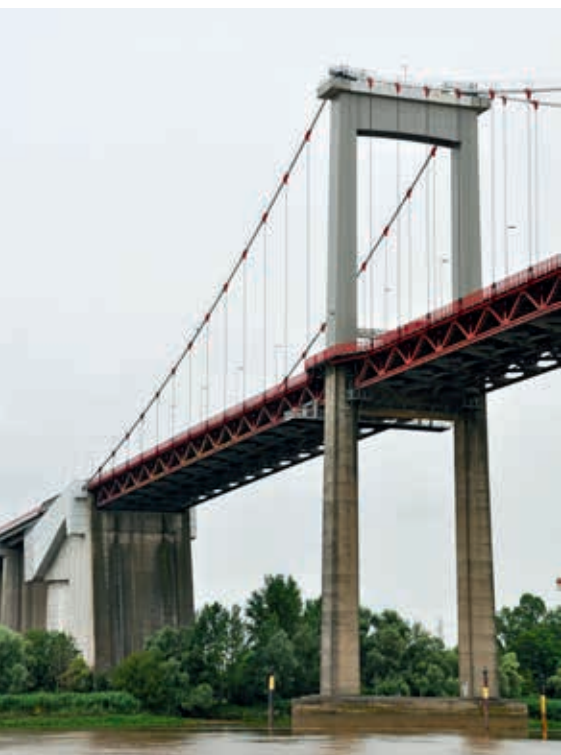
Pylon pont d'Aquitaine (obiekt nr 13)
