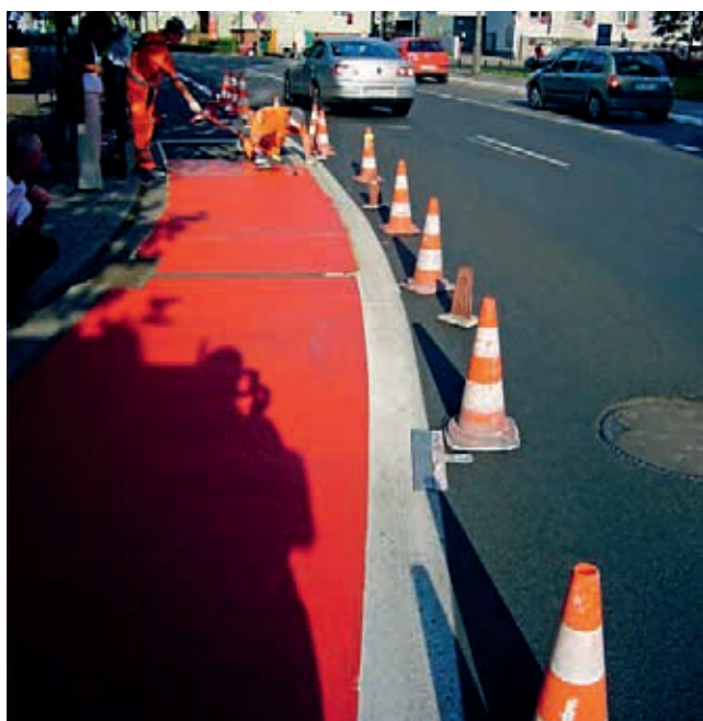
Trwale wytyczone strefy, z odpowiednio dostosowaną, antypoślizgową nawierzchnią, opartą na produktach Degaroute®, fot. Evonic Industries AG
