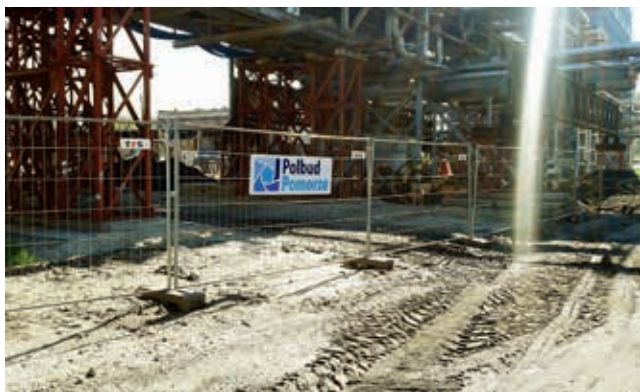
Ryc. 2. Widok miejsca wykonywania robót naprawczych
