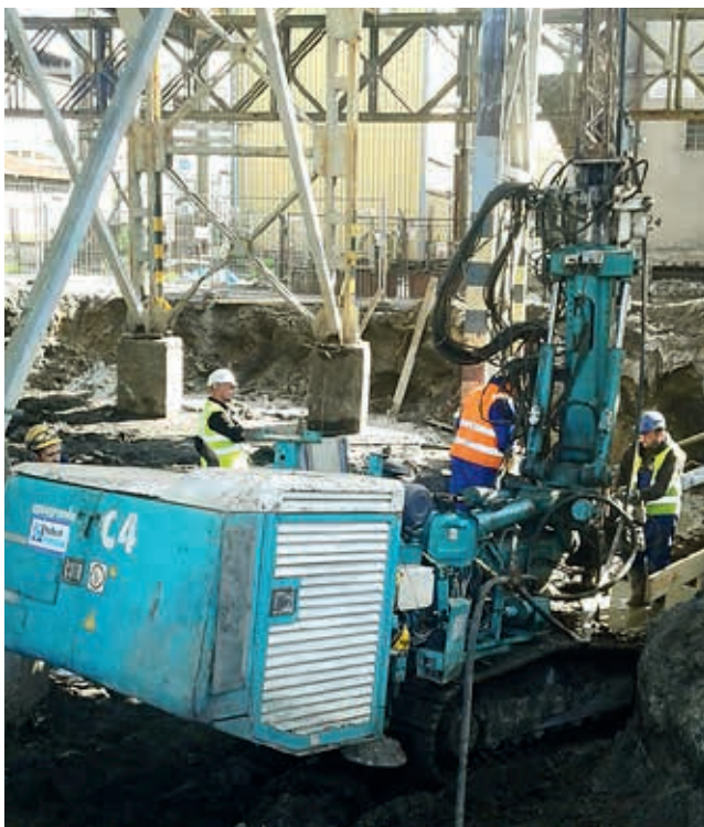
Ryc. 5. Wykonanie robót iniekcyjnych w warunkach kolizji z infrastrukturą przemysłową
