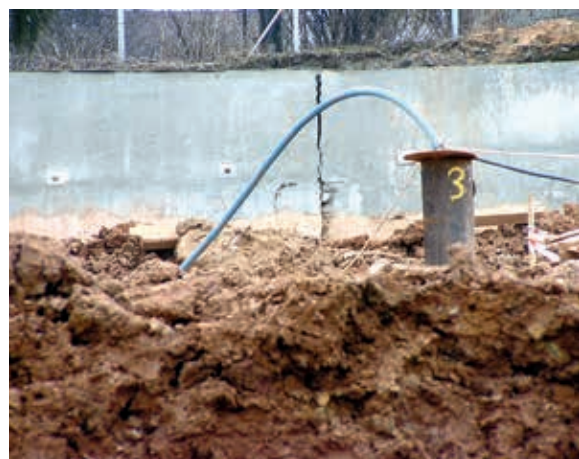
Studnia odwadniająca w rejonie głębokiego wykopu
