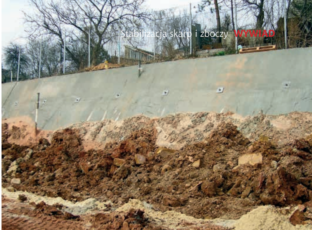
Stanowiska okresowych pomiarów inklinometrycznych
