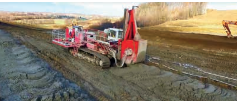
Droga ekspresowa S19 – realizacja wzmocnienia gruntu w technologii Trenchmix
