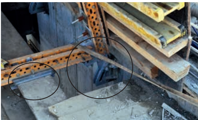
Ryc. 3. Detale umożliwiające odspojenie deskowania metodą hydrauliczną
