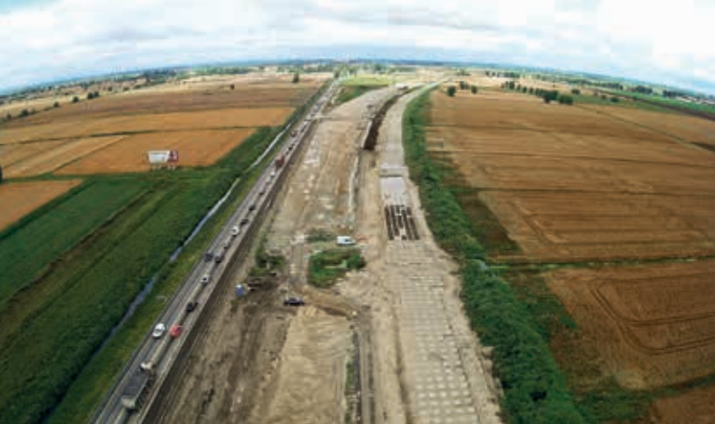
Na drogach P-1, P-24 oraz P-10 trwają roboty przy wzmocnieniu podłoża
