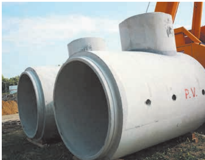
Studzienka zintegrowana, plac budowy przed montażem
