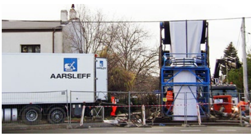
Białystok – renowacja w technologii termoutwardzalnego rękawa Aarsleff
