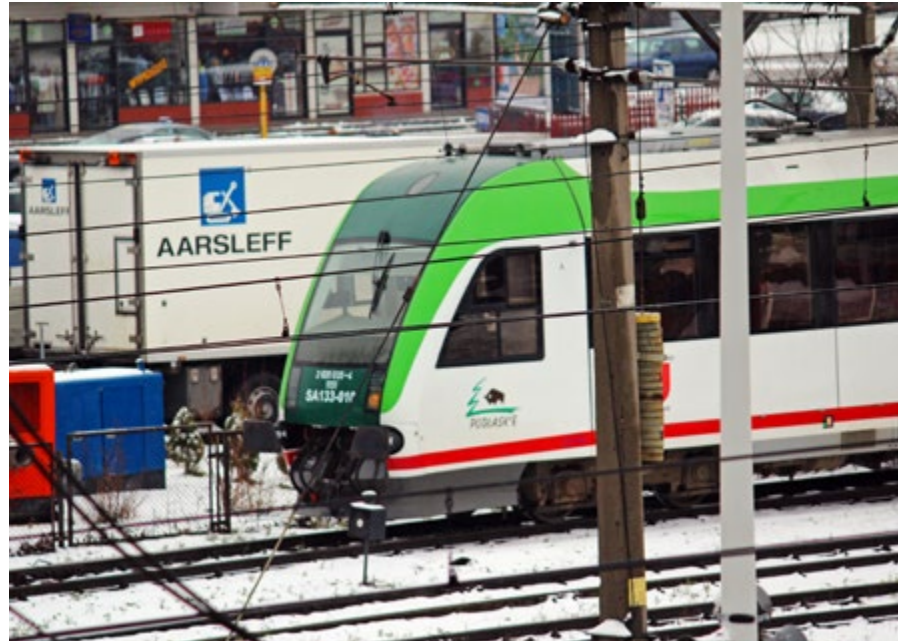
Białystok – renowacja w technologii termoutwardzalnego rękawa Aarsleff
