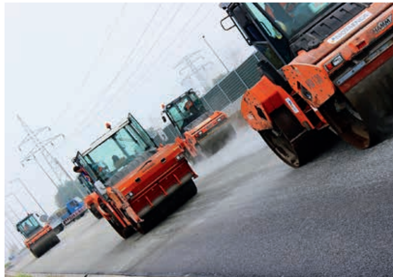
Budowa odcinka obwodnicy Skawiny z zastosowaniem asfaltów nowej generacji ORBITON HiMA, tzw. asfaltów długowiecznych. Projekt zrealizowany został przez Firmę Mota-Engil Central Europe S.A, a asfalty do budowy odcinka dostarczyła Spółka ORLEN Asfalt (wykonanie październik 2014), fot. ORLEN Asfalt Sp. z o.o.
