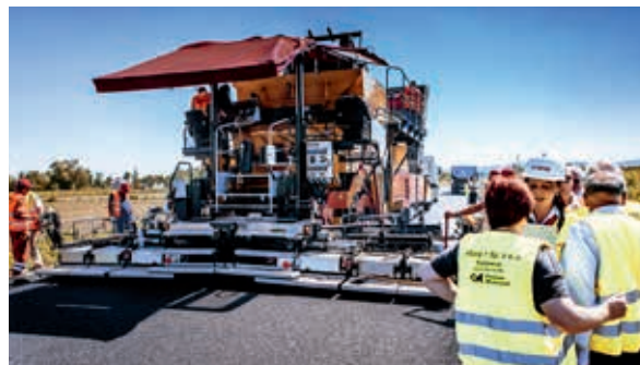
Budowa cichej nawierzchni z zastosowaniem asfaltu MODBIT CR na obwodnicy Gdowa
