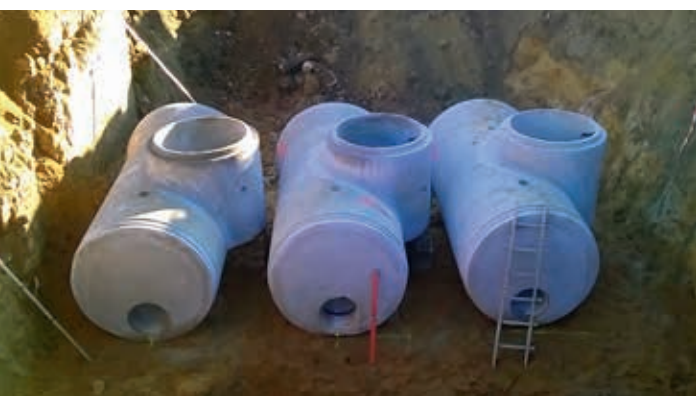
Rura żelbetowa DN 1200 z wbudowaną studnią styczną DN 1000 z zabetonowanym dnem
