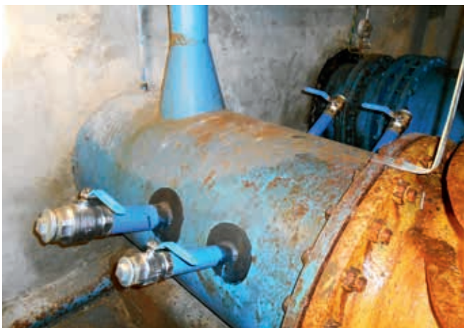
Ryc. 2. Przygotowanie zaworów pod montaż czujników na Kopcu Kościuszki
