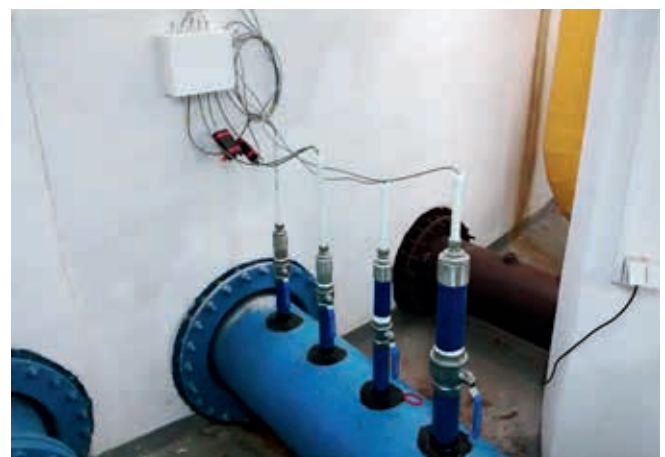
Ryc. 4. Zamontowany komplet czujników wewnątrz rurociągu na os. Złoty Wiek
