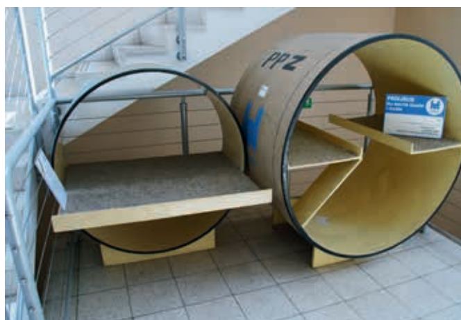
Ryc. 3. Przykładowe dwa typy półek dla zwierząt o konstrukcji kompozytowej zamontowane do konstrukcji rury osłonowej metodą laminowania – ekspozyty dydaktyczne na Uniwersytecie Zielonogóskim. Widoczne wykształcone pochwyty w przypadku obustronnych półek podwieszanych, fot. A. Wysokowski
