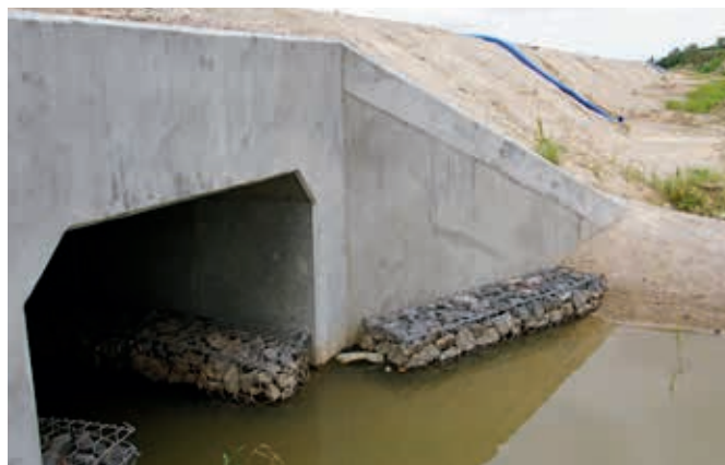
Ryc. 2. Przykład obustronnych półek dla zwierząt wykonanych z gabionów usytuowanych na dnie konstrukcji w trakcie realizacji przejścia o funkcji zespolonej, fot. A. Wysokowski
