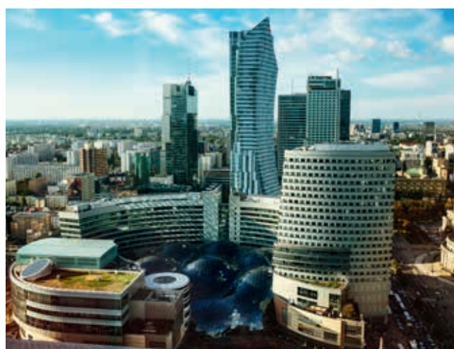
Budowy gazociągu dla projektu Złote Tarasy w Warszawie w technologii przewiertu sterowanego zrealizowana przez firmę JT Zakład Budowy Gazociągów z Warszawy, fot. Castenoid, fotolia
