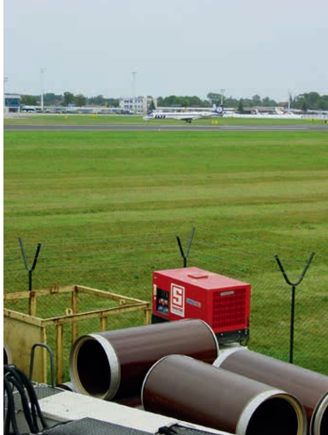
Rury kamionkowe firmy Keramo Steinzeug N.V. DN 800 z przeznaczeniem do mikrotunelowania na lotnisku w Gdańsku Rębiechowie
