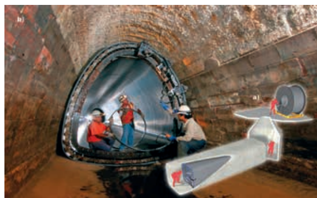
Zastosowanie technologii SPR w kanale dzwonowym o wymiarach 1800 x 2600 mm przez firmę Infra SA
