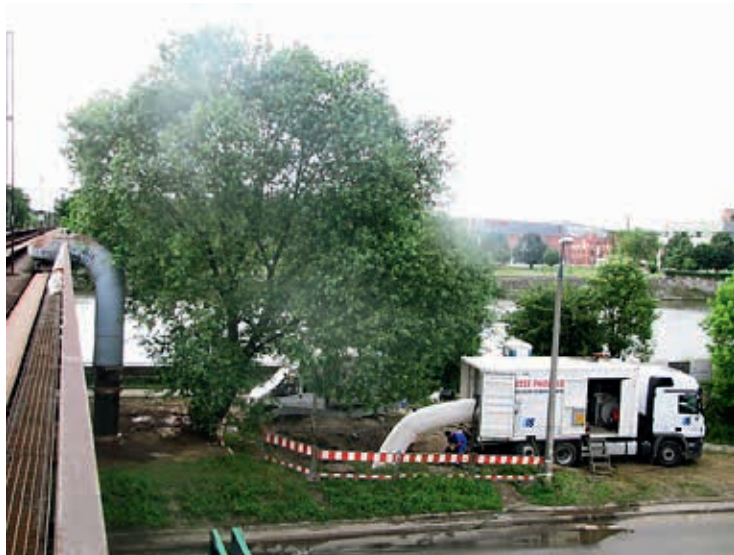
Renowacja odcinka magistrali wodociągowej w Krakowie metodą Process Phoenix-Double Jacket, zrealizowana przez firmę Preuss Pipe Rehabilitation Polska Sp. z o.o.
