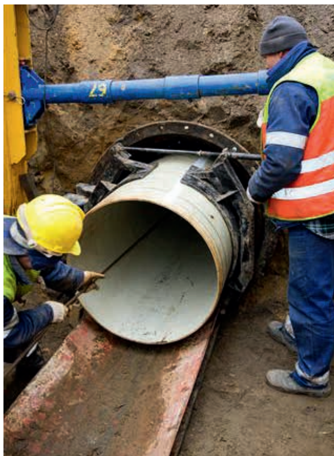
Rehabilitacja magistrali wodociągowej w Łodzi rurami GRP Flowtite metodą reliningu zrealizowana przez firmę Amitech Poland Sp. z o.o.
