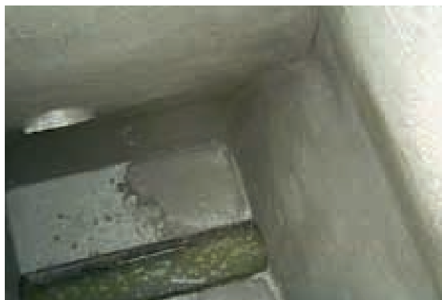
Studnia poddana renowacji przy zastosowaniu Ombran MHP [5]
