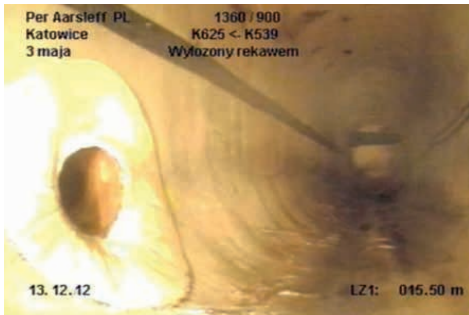
Widok wnętrza kanału po bezwykopowej rehabilitacji kolektora kanalizacyjnego w Katowicach wykonanej przez firmę Per Aarsleff Polska Sp. z o.o.
