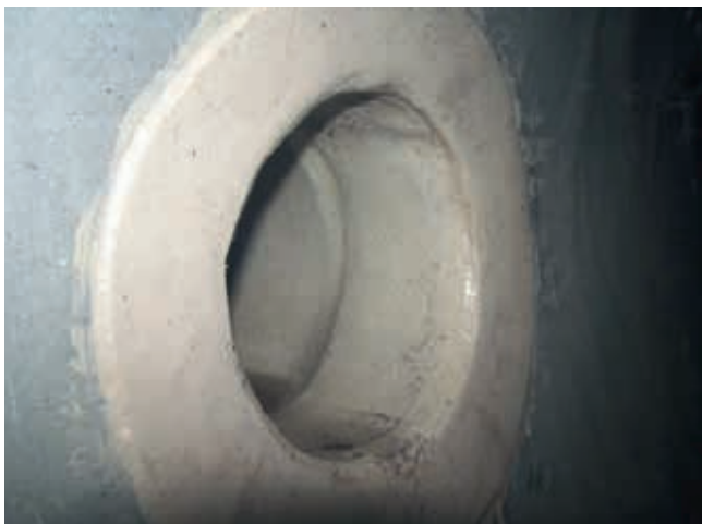
Renowacja przykanalików przy zastosowaniu kształtki kapeluszowej, wykonana przez firmę Infra z grupy PBG SA
