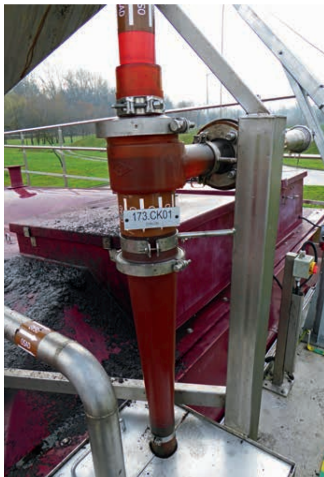
Instalacja deamonifikacji – cyklon
