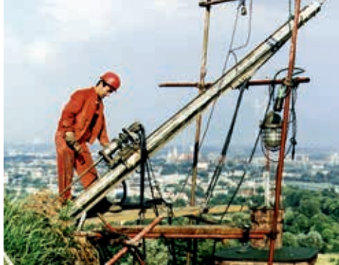
Prace zabezpieczające Kopiec Kościuszki
