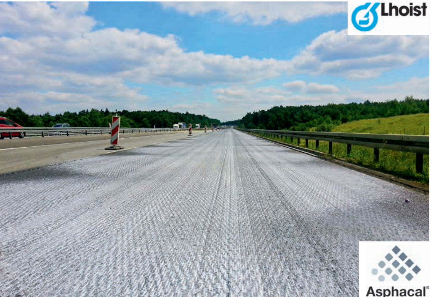
Zabezpieczenie warstwy szczepnej podczas wymiany warstwy ścieralnej na autostradzie A4, fot. Lhoist
