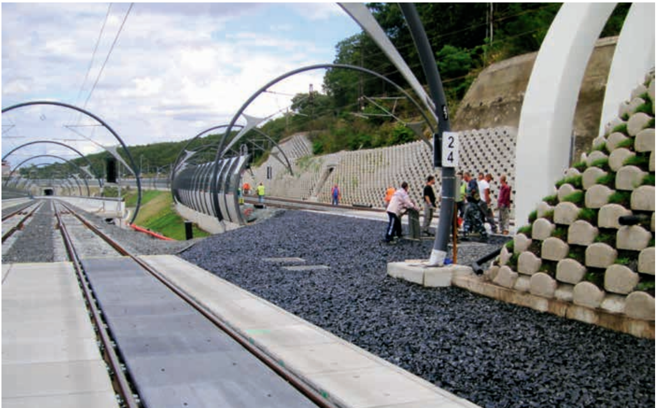
Zabezpieczenie możliwości ruchu na drogach ewakuacyjnych – obwodnica Pragi czeskiej
