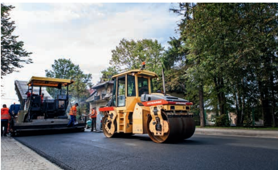
Budowa drogi nr 957 w Nowym Targu, na której położono asfalt modyfikowany z dodatkiem gumy, fot. LOTOS Asfalt Sp. z o.o.
