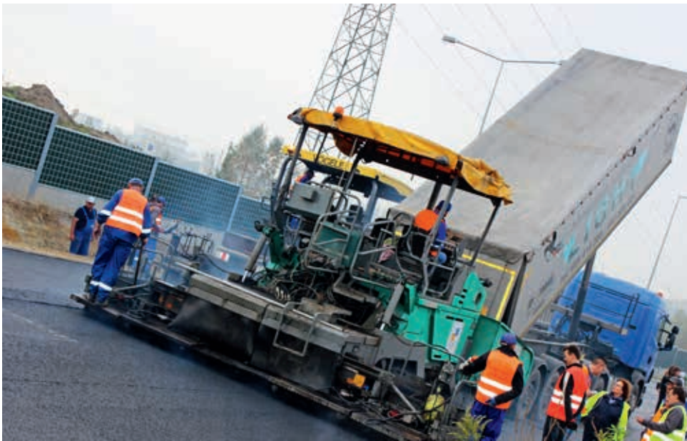
Budowa odcinka obwodnicy Skawiny z zastosowaniem asfaltów nowej generacji ORBITON HIMA, fot. ORLEN Asfalt Sp. z o.o.
