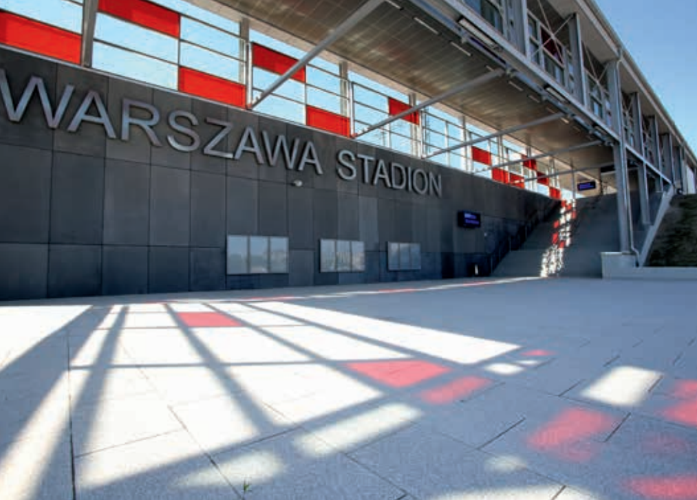
Stacja Warszawa Stadion, wykonawca Bilfinger Infrastructure SA
