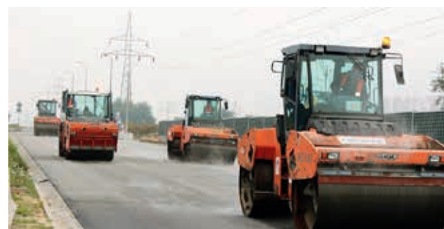
Ryc. 5. Wykonanie odcinka z Orbitonem 45/80-80 HiMA w 2014 r. – nawierzchnia na obwodnicy Skawiny, fot. Orlen Asphalt Sp. z o.o.
