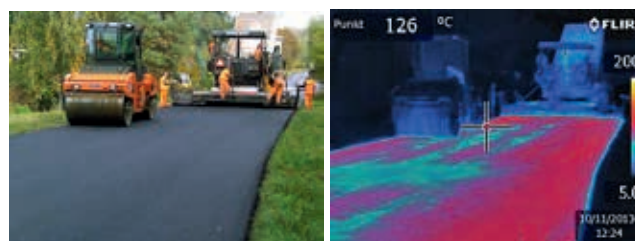
Ryc. 4. Wykonanie pierwszego odcinka doświadczalnego z Orbitonem 65/105-80 HiMA w 2013 r. – rejestracja zmiany temperatury mieszanki podczas zagęszczania, fot. Orlen Asphalt Sp. z o.o.
