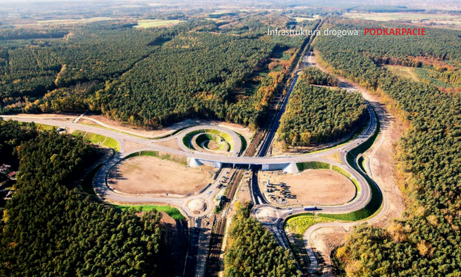
Widok na węzeł Las Klasztorny – II etap obwodnicy Leżajska
