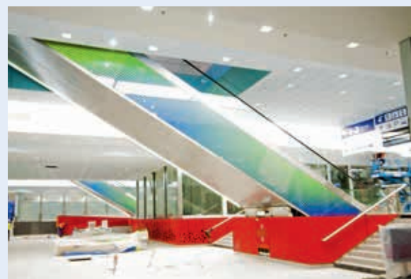
Budowa dworca kolejowego Kraków Główny, zintegrowanego z miejskim transportem publicznym w Krakowie
