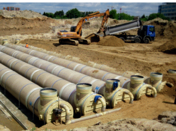
Ryc. 11. Przykładowy zbiornik retencyjny do zabudowy w wykopie otwartym [13]
