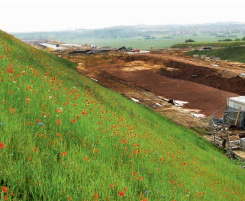
Ryc. 1. Stabilizacja skarp z wykorzystaniem systemu TECCO, fot. Geobrugg Partner in Poland
