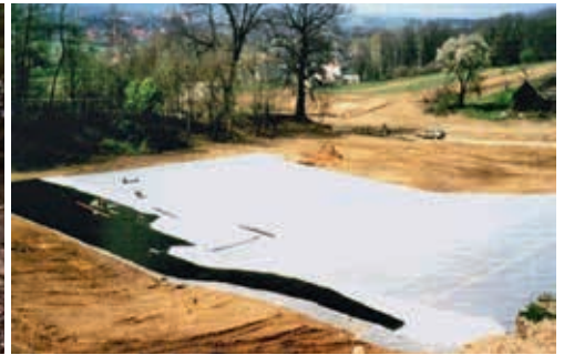
Odbudowa osuwiska Falkowa – montaż geowłókniny i geokraty
