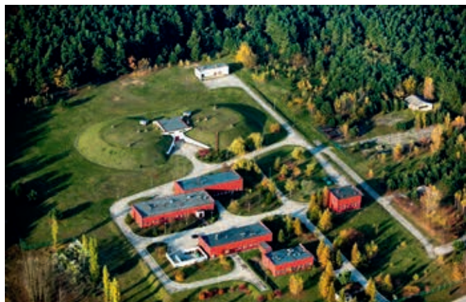
Ujęcie wody na Białogonie współcześnie, fot. Wodociągi Kieleckie Sp. z o.o.
