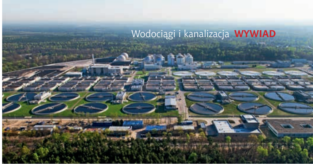
Panorama Oczyszczalni Ścieków „Czajka”, fot. Kacper Kowalski/aeromedia.pl
