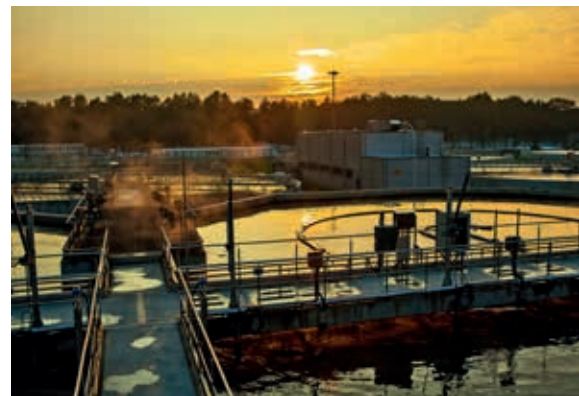
Reaktory biologiczne na terenie Oczyszczalni Ścieków „Czajka”, fot. Krzysztof Kobus/Travelphoto
