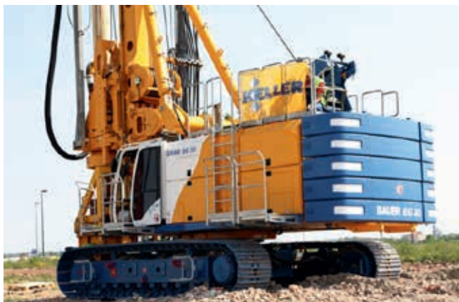
Ryc. 4. Jedna z maszyn wykorzystywanych do wykonywania pali CFA 800 mm
