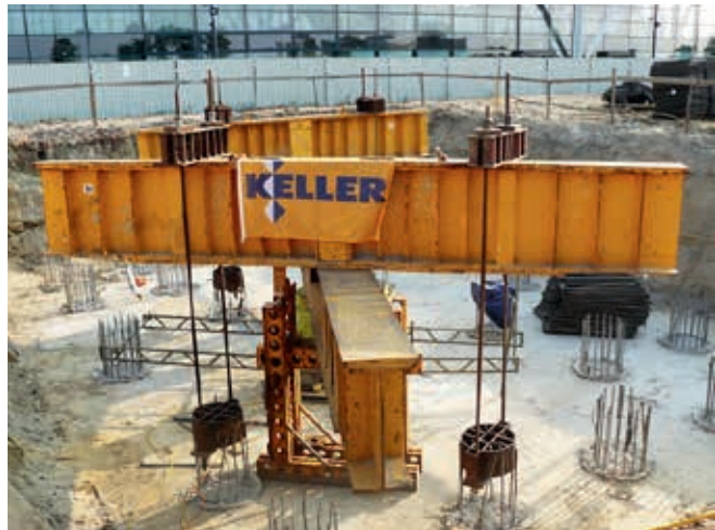
Ryc. 5. Stanowisko do badania statycznego pala konstrukcyjnego
