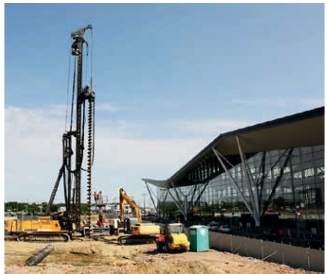
Ryc. 1. Wykonywanie pali CFA Ø 800 mm pod fundamenty obiektu WK36 Pomorskiej Kolei Metropolitalnej
