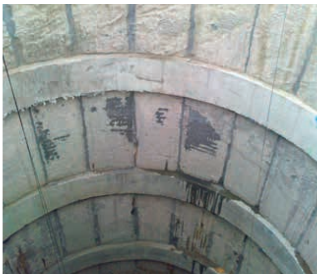
Ryc. 3. Budowa komory cylindrycznej prawie ukończona; kontrola jakości i odbiór wymagały użycia kabiny opuszczanej żurawiem
