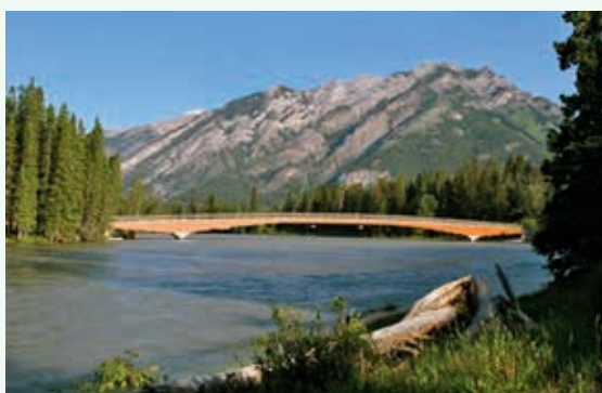
Ryc. 7. Kładka Bow River Bridge, Banff Kanada – zwycięzca w kategorii dużych kładek. Konstrukcja z drewna klejonego, rozpiętość głównego przęsła 80 m
