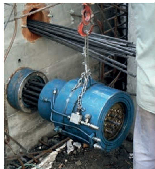
Ryc. 12. Prasa naciągowa w trakcie nakładania na końcówkę kabla, fot. P. Gwoździewicz
