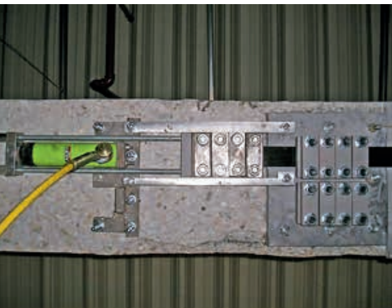
Ryc. 8. Złożone z blach stalowych zakotwienie taśm sprężających CFRP w trakcie naciągu ciężna, fot. W. Derkowski
