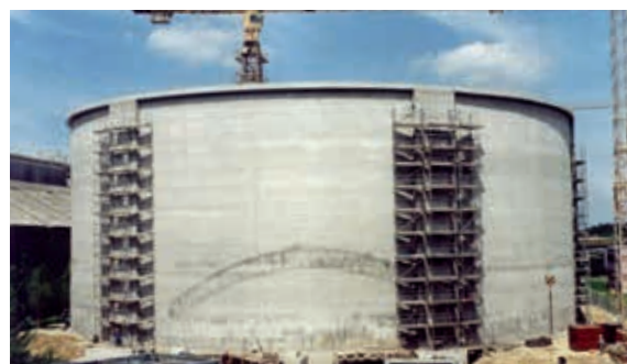
Ryc. 18. Silos na klinkier w Cementowni Góraždze, fot. P. Gwoździwicz
