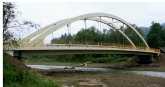
Ryc. 15. Kładka pieszo-jezdna przez potok Stomka w Budzowie, fot. P. Gwoździwicz
