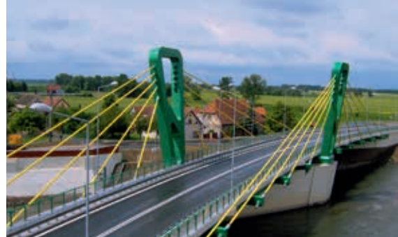
Ryc. 14. Most przez Nysę Kłodzką w ciągu DK94 w Skorogoszczu, fot. T. Miernik
