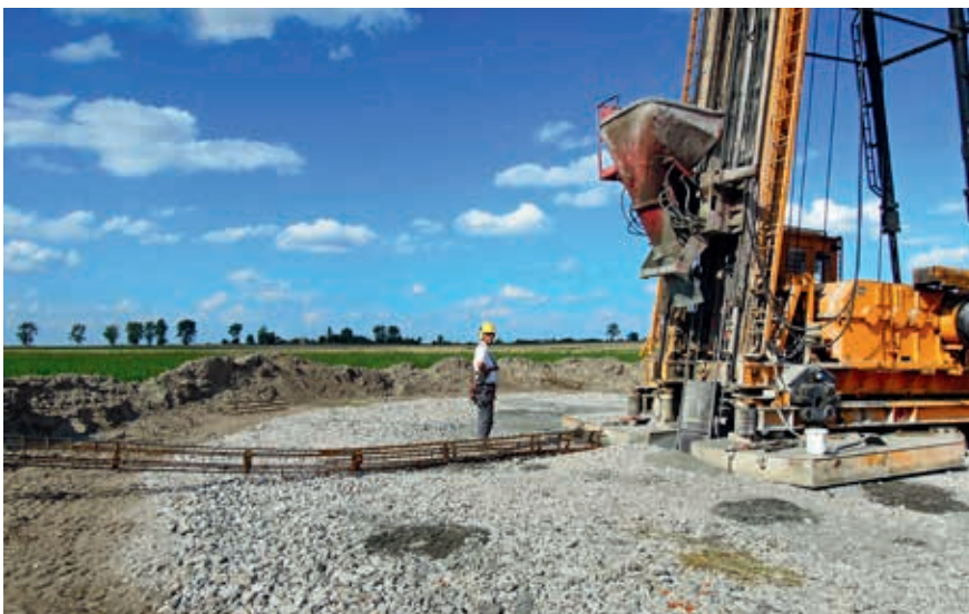
Wykonywanie pali przemieszczeniowych FRANKI NG, fot. FRANKI SK Sp. z o.o.
