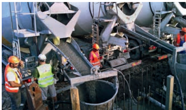
Betonowanie sekcji ścian szczelinowych, fot. archiwum Soletanche Polska Sp. z o.o.
