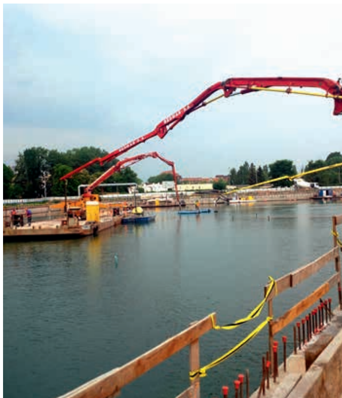
Widok na budowę – przepompowywanie betonu z pompy na brzegu do pompy na platformie pływającej, fot. archiwum Soletanche Polska Sp. z o.o.
