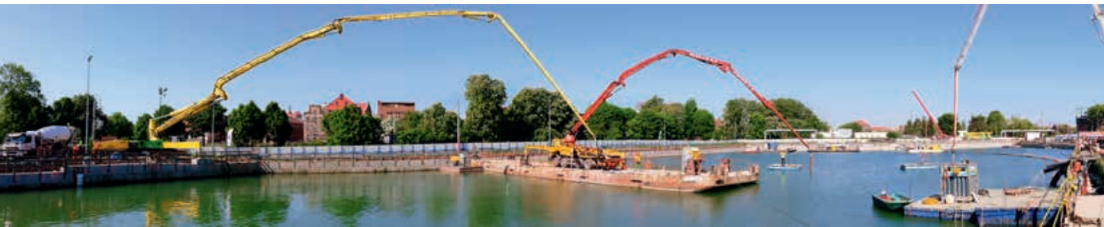
Widok budowy w trakcie betonowania korka podwodnego, fot. archiwum Soletanche Polska Sp. z o.o.
