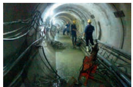
Ryc. 8. Wnętrze kanału w trakcie budowy
