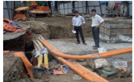
Ryc. 6. Wnętrze wykopu – różne rury istniejące w wykopie na różnych poziomach
