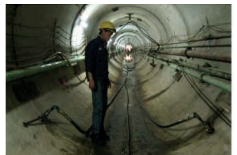
Ryc. 7. Pompowanie bentonitu przez ściankę rury
