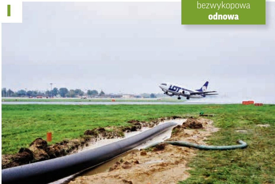
Uponor Infra Sp. z o.o., Relining długimi rurami WehoPipe
