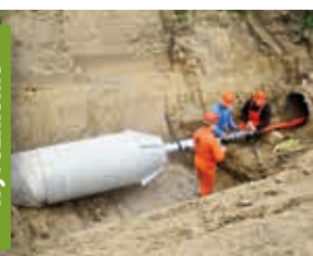
DTA-Technik Sp. z o.o., Kraking sieci kanalizacyjnej GrundoBURSTem
