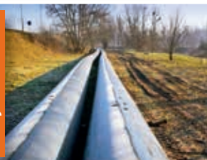
Aquanet SA, Rurociągi tłoczne do podziemnego przewiertu pod rzeką Wartą
