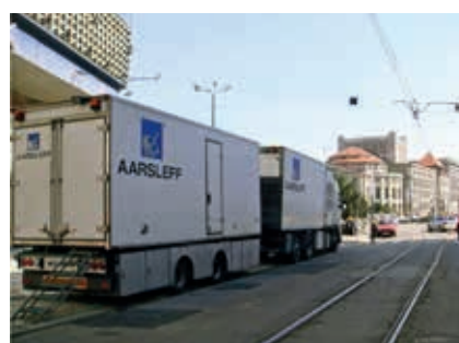
Prace przygotowawcze do instalacji dolnego rękawa
