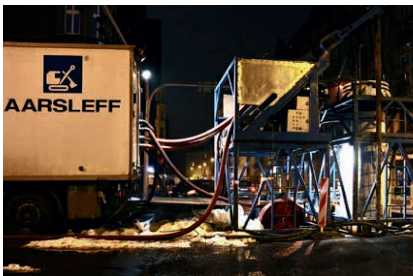
W trakcie instalacji górnego rękawa
