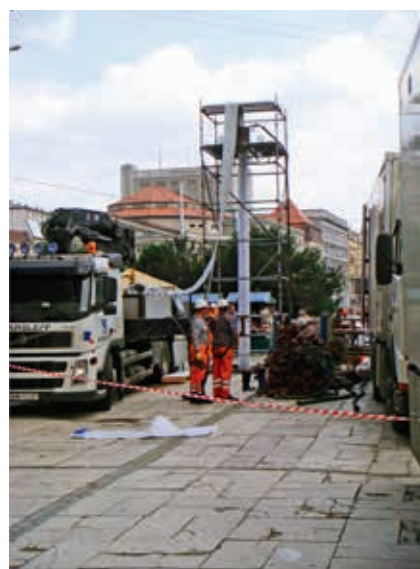
Rozpoczęcie instalacji dolnego rękawa
