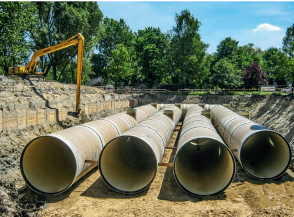
Montaż zbiornika podziemnego w centrum miasta
