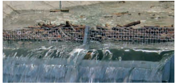
Ryc. 1. Najprostszy system przeciwrumowiskowy, schemat działania oraz zdjęcie obiektu w eksploatacji, źródło: Geobru gg AG
