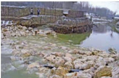
Ryc. 18. Widoczna elastyczna bariera stabilizująca dno koryta na odcinku posadowienia mostu
