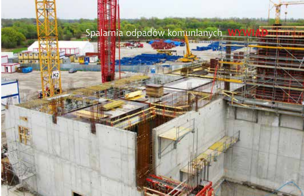
Główny budynek procesowy ZTPO – widok z hali rozładunkowej na bunkier i garaże
