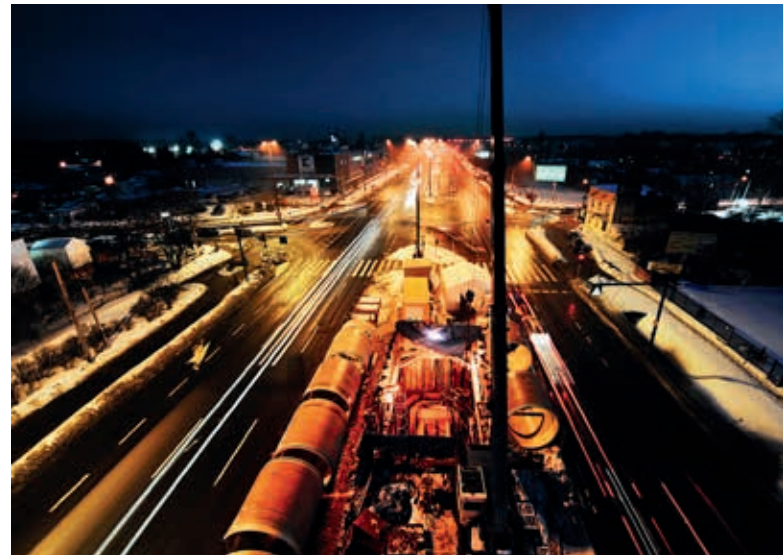
Laureat w kategorii bezwykopowa budowa, HOBAS System Polska Sp. z o.o., Kolektor odprowadzający do Oczyszczalni Ścieków „Czajka”
