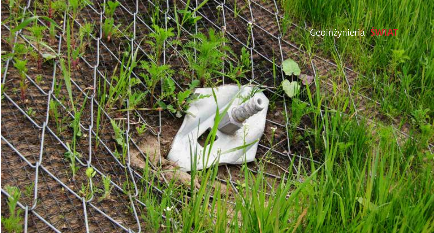
Zastosowanie systemu TECCO, skuteczna stabilizacja skarpy
