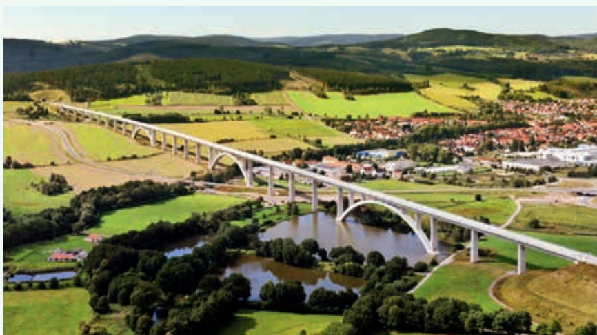
Ryc. 2. Most Ilmatal w ciągu linii kolejowej w Niemczech, fot. H. Dietz, Nürnberg Luftbild
