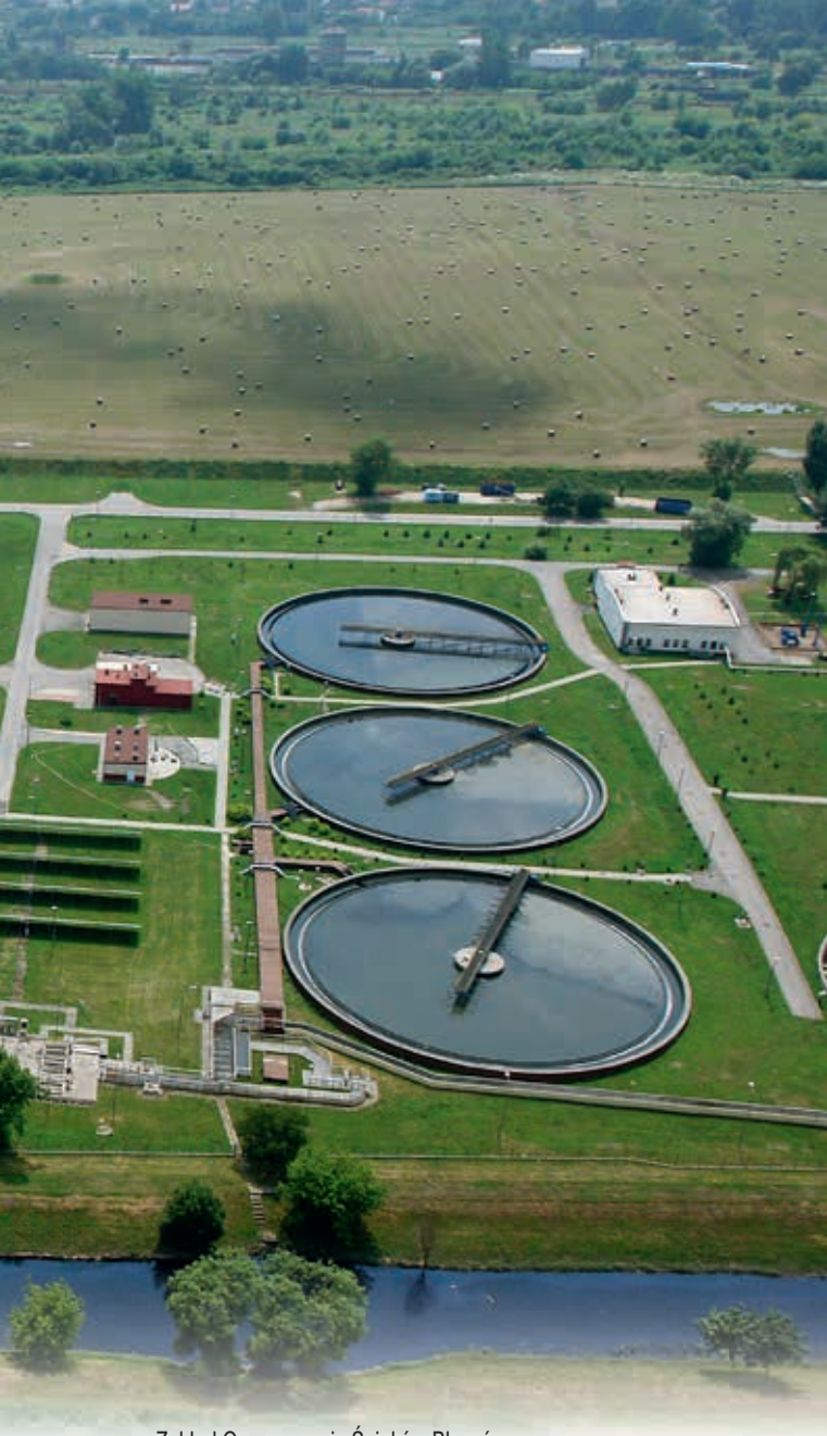
Zakład Oczyszczania Ścieków Płaszów
