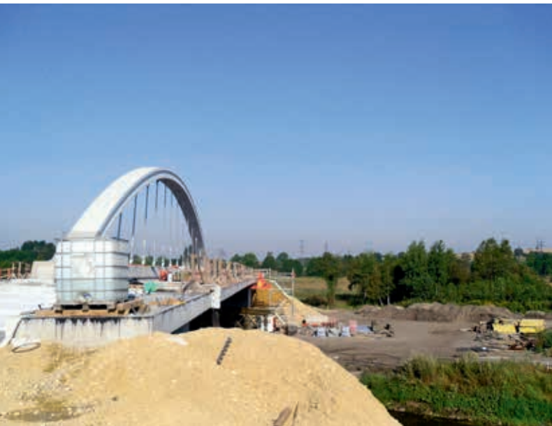
Most w Chełmku w trakcie budowy
