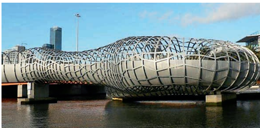
Ryc. 11. Intrygująca forma kładki przez Yarrę w Melbourne
