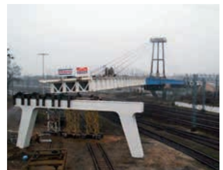
Ryc. 2. Nasuwanie konstrukcji nad czynnymi torami kolejowymi
