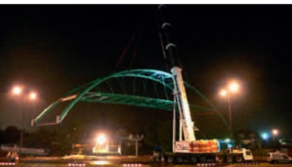
Ryc. 9. Montaż gotowej kładki nad drogą szybkiego ruchu w mieście
