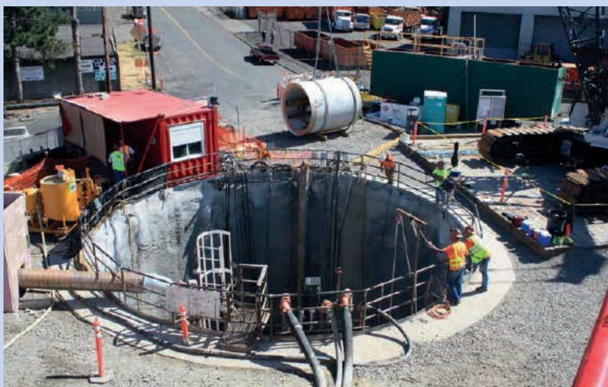
Ryc. 6. Szyb startowy urządzenia TBM [1]
