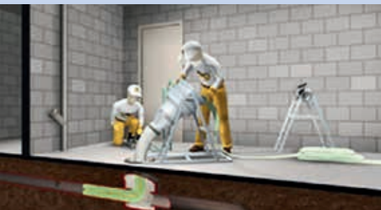
Ryc. 7. Wprowadzenie powłoki do wnętrza przykanalika [5]
