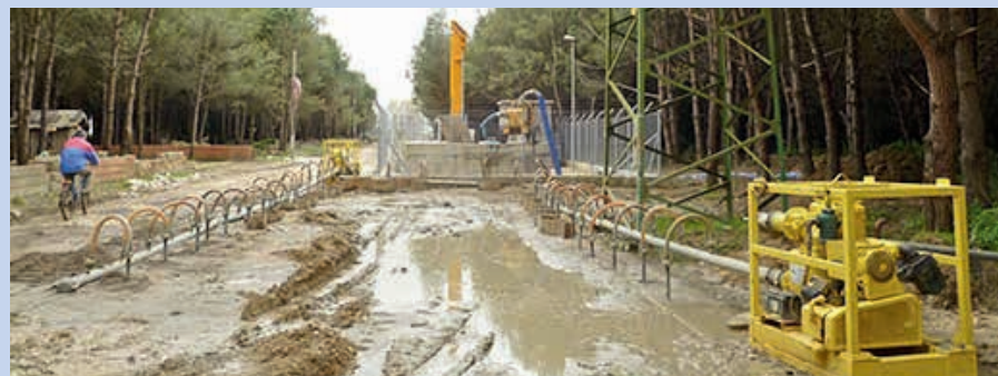
Ryc. 3. Warunki gruntowo-wodne na placu budowy, Albania [4]
