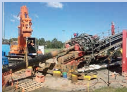
Ryc. 5. Wiertnica Coe Drilling's Prime PD500 w czasie pracy [1]
