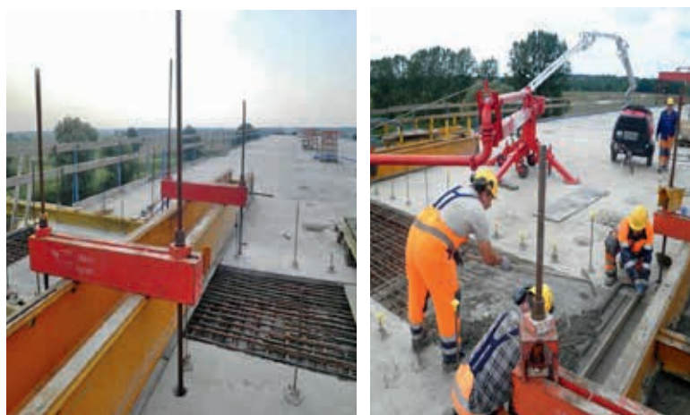
Ryc. 10. Konstrukcja wyrównawcza zwornika D–E oraz betonowanie zwornika nurtowego D–E
