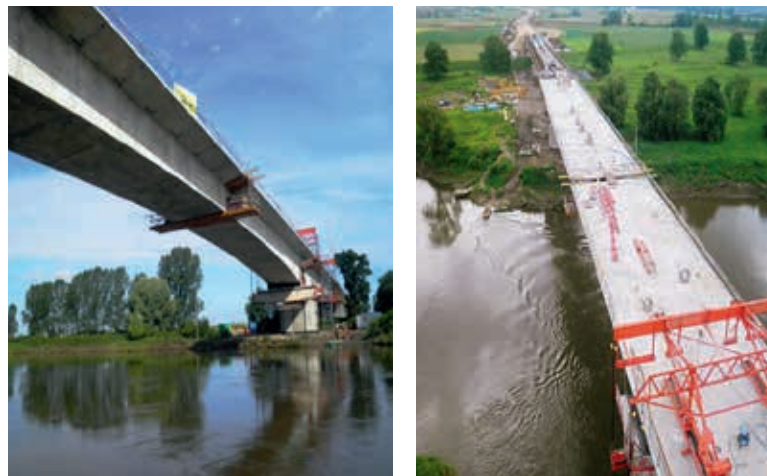
Ryc. 11. Widok na segment zwornikowy D–E tuż przed uciągnięciem całości konstrukcji mostu
