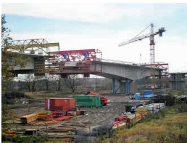
Ryc. 2. Widok na most w trakcie budowy sekcji nawisowych C i D
