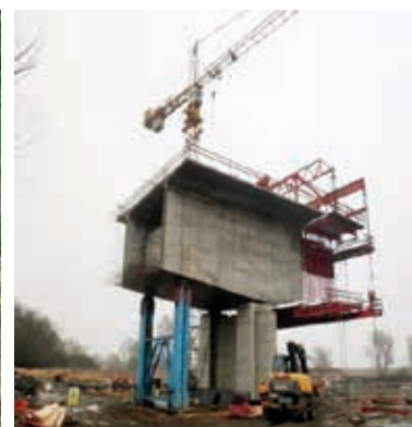
Ryc. 3. Widok na segment startowy D przed betonowaniem I etapu oraz montaż wózków na segmencie E
